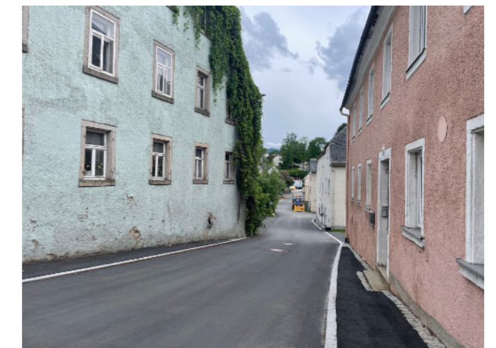
Abb.6: Sanierungsbedürftige Gebäude an der Humbertstraße
