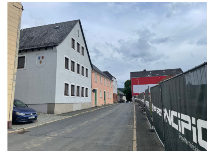
Abb.38: Baustelle für Wohnungsneubauten an der Weißdorfer Straße
