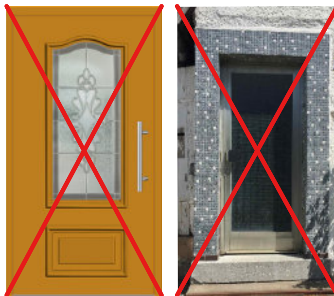
Abb. 59 - Negativ: Eingangstüren aus Kunststoff mit grellen Farbtönen sind unpassend für historische Gebäude.
