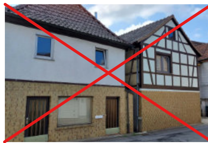
Abb. 42 - Negativ: unpassende Fassadenverkleidung, unterschiedliche Fensterformate, kein Fassadengliederungsprinzip ablesbar
