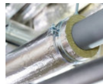
Abb. 145 - Dämmung der Versorgungsleitung
