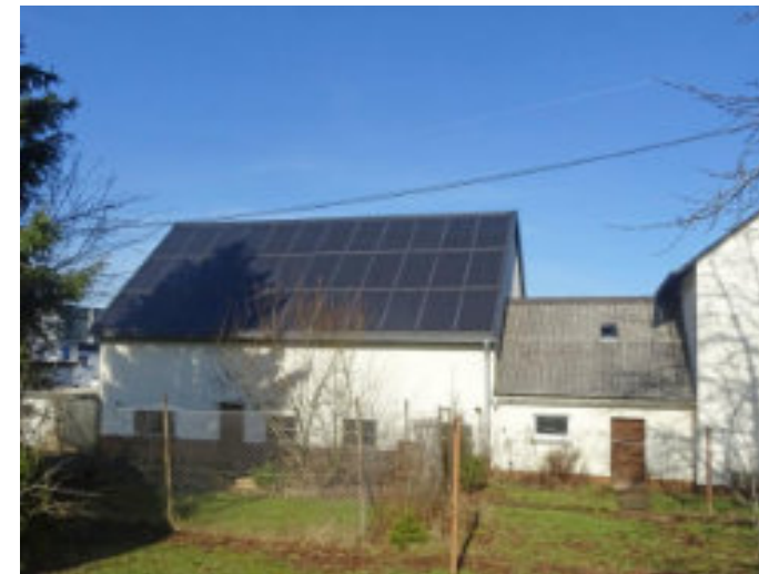
Abb. 134 - Farblich gelungene Integration von Solarmodulen auf dem Nebengebäude
