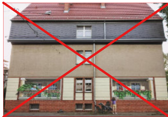
Abb. 100 - Negativ: Die Dachfläche sollte einheitlich gedeckt sein.
