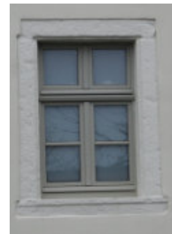
Abb. 67 - Neues Holzfenster mit waagrechten Sprossen dem historischen Vorbild nachempfunden.
