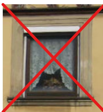
Abb. 79 - Negativ: Ein aufgesetzter Rollokasten dominiert optisch das Fenster. Die historische Fassade wird dadurch empfindlich gestört.
