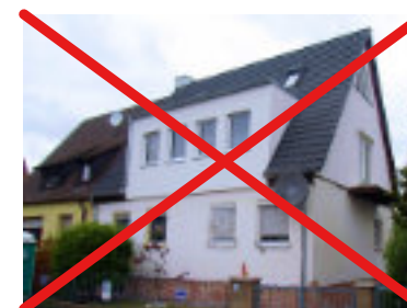
Abb. 120 - Negativ: überdimensioniertes Zwerchhaus
