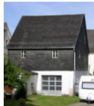
Abb. 98 - Schiefer als Dacheindeckungsmaterial und als Verkleidung der Fassade
