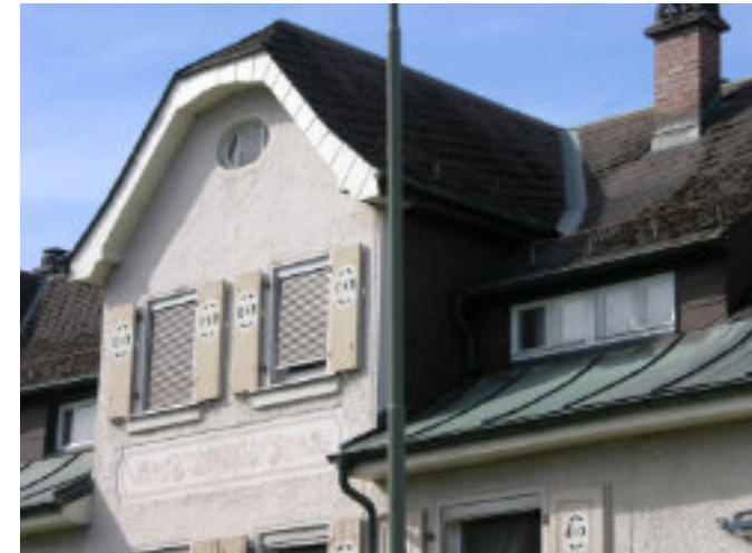
Abb. 119 - Zwerchhaus mit Krüppelwalmdach
