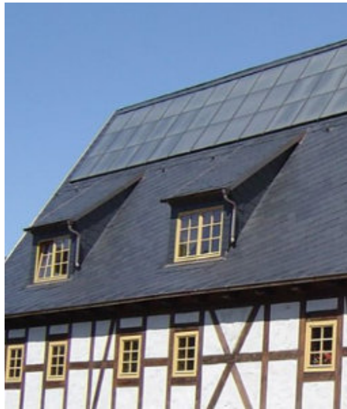
Abb. 130 - Gut integrierte Solaranlage auf einem Schieferdach durch unauffällige Module in einheitlicher Farbfassung (ohne weiße Punkte oder Streifen) und farblich angepassten Rahmen.
