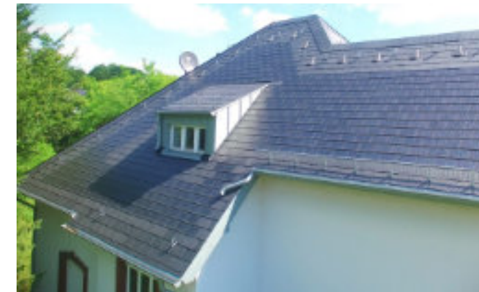
Abb. 127 - Gelungene Integration von Solarziegeln in der historischen Dachfläche
