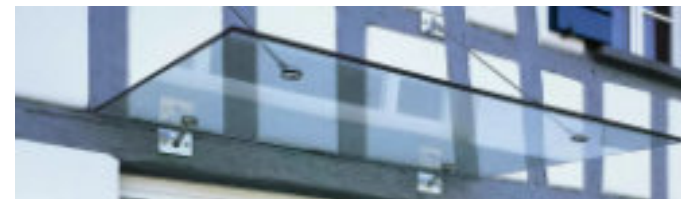
Abb. 64 - Im Allgemeinen sollte auf ein modernes Vordach an einem historischen Gebäude nach Möglichkeit (vor allem an öffentlichen Verkehrspunkten) verzichtet werden bzw. dieses so zurückhaltend wie möglich ausgeführt werden (z. B. punktgehaltenes Glasdach).
