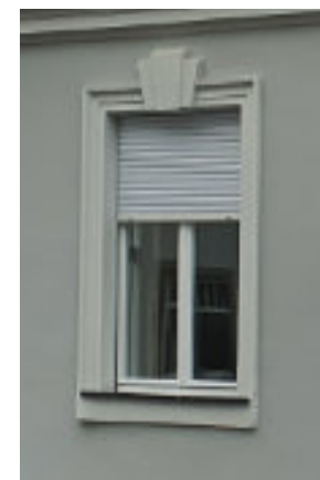
Abb. 82 - Von außen unsichtbare Einbaurollläden, deren Rollokästen versteckt eingebaut wurde, bietet sich auch für historische Fassaden an.
