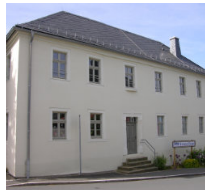
Abb. 6 - Positiv: Objektgerechte Sanierung
