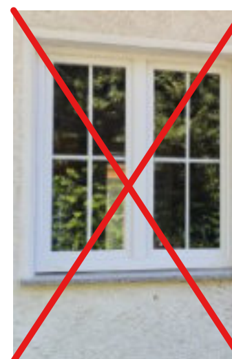
Abb.69 - Negativ: innenliegende, aufgeklebte Fenstersprossen
