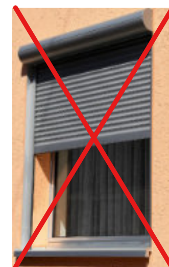
Abb. 70 - Negativ: Einscheibenfenster und außenliegende Rollläden im Altbau
