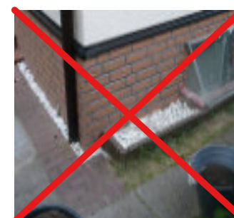
Abb. 53- Negativ: auf ortsuntypische Materialien wie Kunststoffputze und industriell hergestellte Verkleidungen (z. B. mit Klinkerplatten, Fliesen und Metallpaneele) sollte verzichtet werden.
