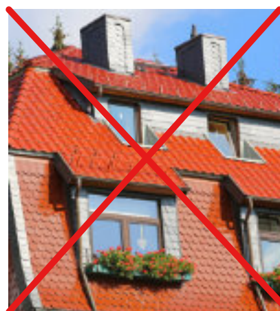
Abb. 112 - Negativ: Überladene Dachfläche mit überdimensionierten Gauben, störende Dachflächenfenster
