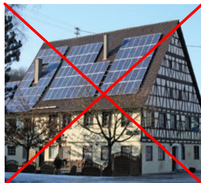
Abb. 126 - Negativ: Einsehbare Solaranlage auf historischem Hauptgebäude
