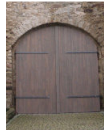
Abb. 63 - Das neue Garagentor wurde im historischen Stil aus senkrechten Holzlatten gebaut. Passende Türbeschläge wurden montiert.
