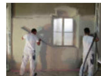
Abb. 143 - Innenwanddämmung mit Dämmputz
