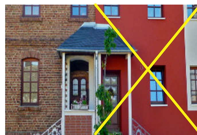
Abb. 172 - Negativ: Die Außendämmung auf der rechten Hausseite vernichtet die Charakteristik des Hauses.
