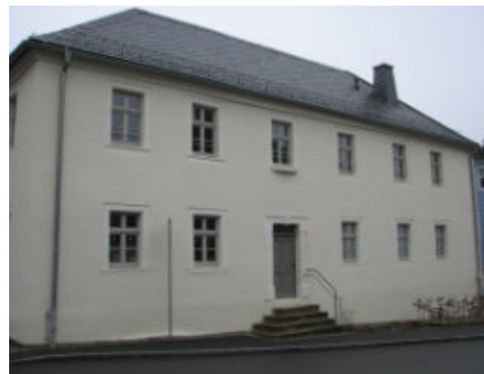
Abb. 137 - Sanierung eines historischen Gebäudes ist immer klimaneutraler als neues Bauen.
