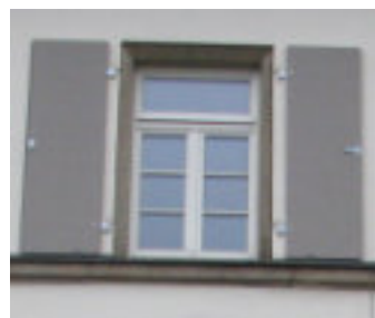
Abb. 76 - Klappläden aus Holz werten die Fassade optisch auf und bieten gleichzeitig Verdunklung und Verschattung.
