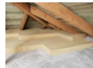
Abb. 141 - Dämmung der oberen Geschossdecke
