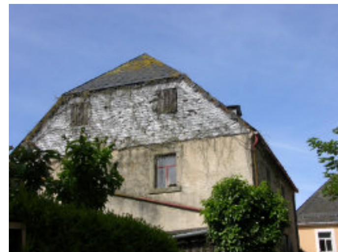
Abb. 50 - Kombination: Bruchsteinfassade (teilweise verputzt) mit Schiefergiebel und -dach
