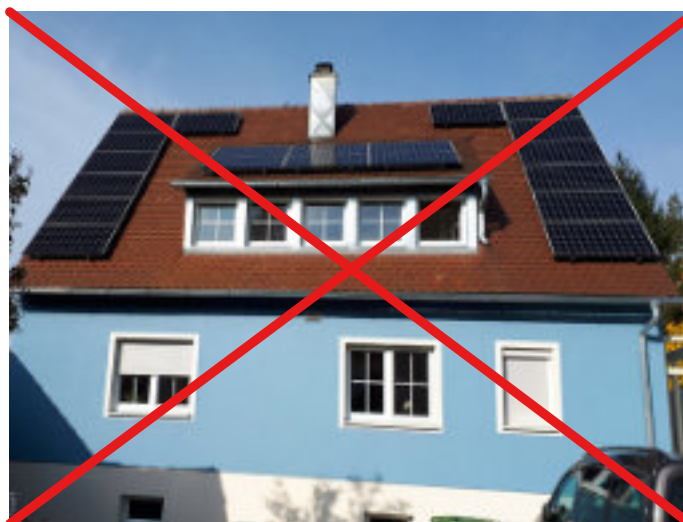
Abb. 132- Negativ: Die Aufteilung von Solarkollektoren auf dem Dach hat erhebliche Nachteile: statt großflächiger Abschnitte entstehen optische Löcher und eine unerwünschte Segmentierung.
