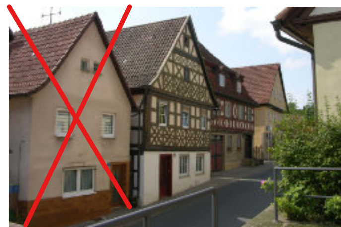
Abb. 146 - Negativ: von außen gedämmt und verputzte Fachwerkfassade
