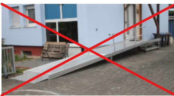
Abb. 199 - Negativ: vorgebaute Metallrampe
