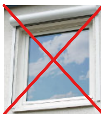
Abb. 79 - Negativ: Ein aufgesetzter Rollokasten dominiert optisch das Fenster. Die historische Fassade wird dadurch empfindlich gestört.
