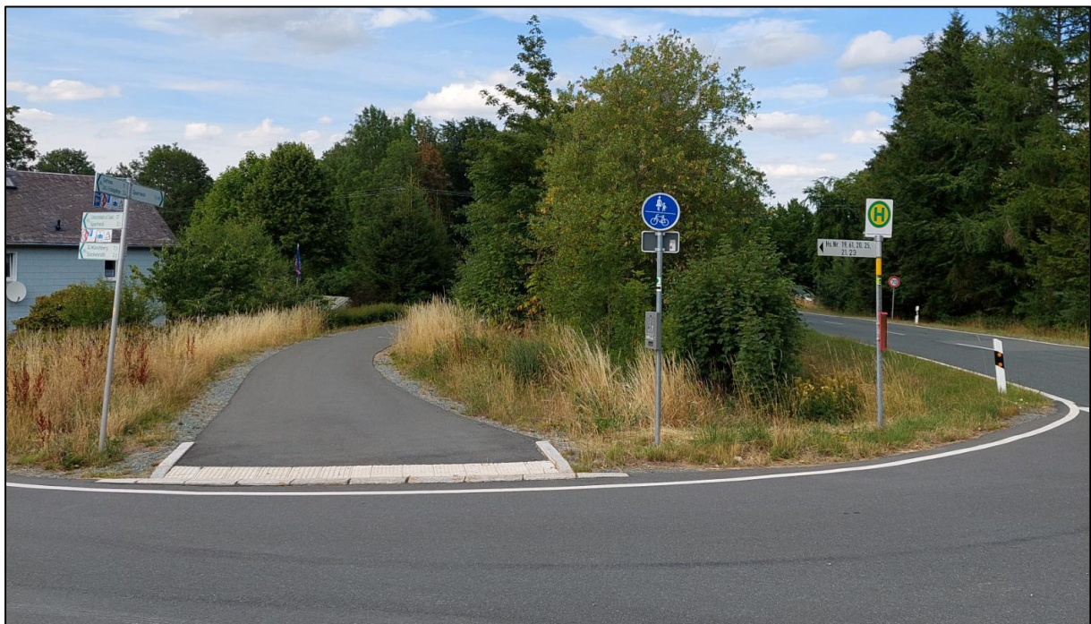
Abbildung 75: Sicht vom Ortsausgang Reinersreuth bzw. vom Standort der möglichen „Trinkwassertankstelle“ auf den gemeinsamen Geh- und Radweg in Richtung Sparneck
