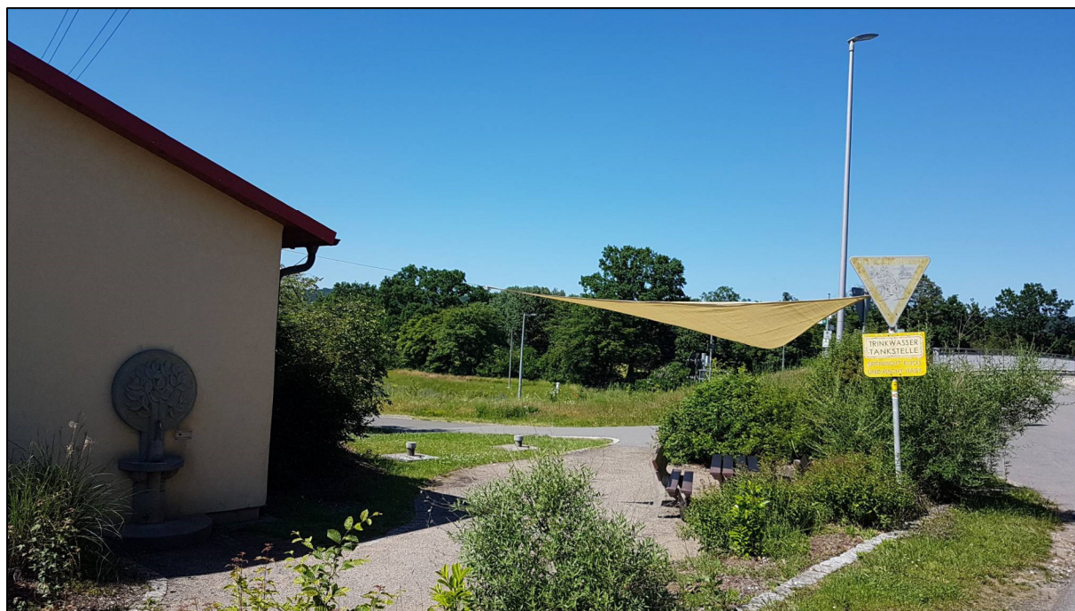
Abbildung 77: Trinkwassertankstelle Staustufe Limbach
