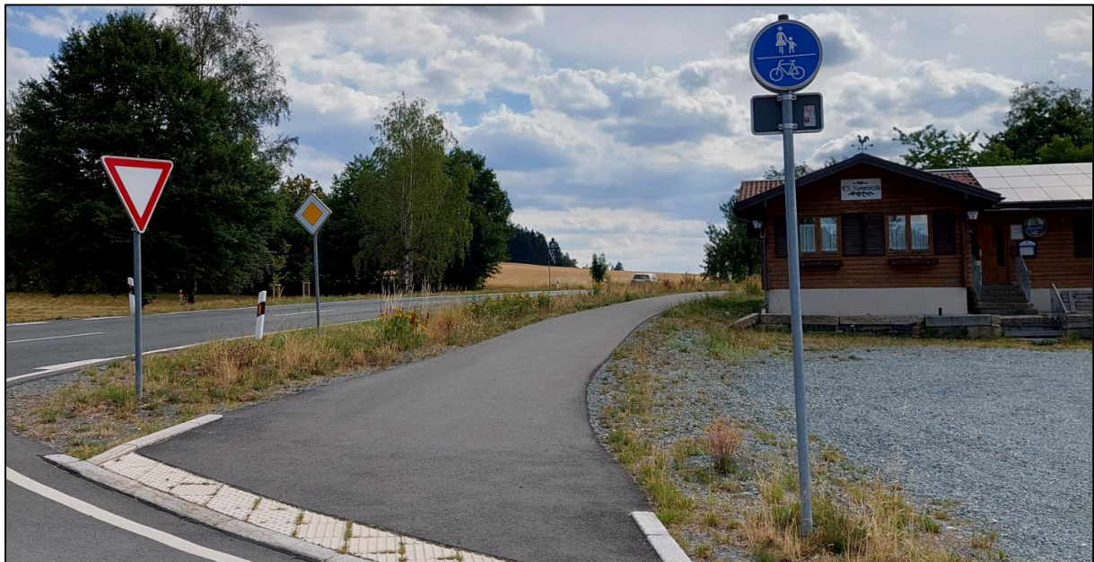
Abbildung 74: Sicht vom Ortsausgang Reinersreuth auf den gemeinsamen Geh- und Radweg in Richtung Zell i.F.
