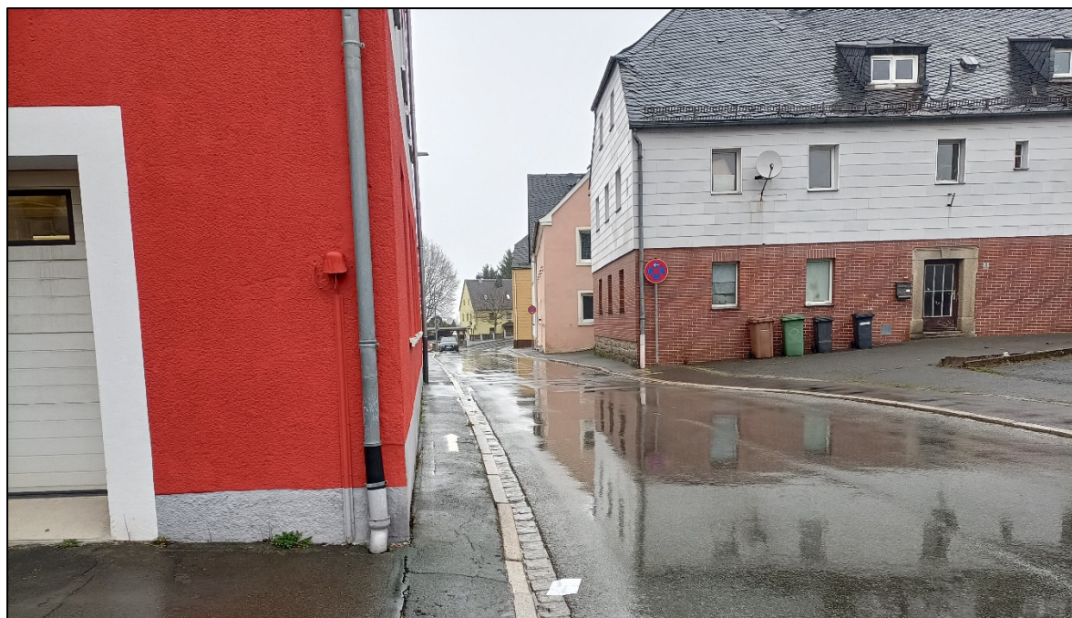
Abbildung 37: Gehweg-Engstelle bei der Weißdorfer Straße 1 und 2
