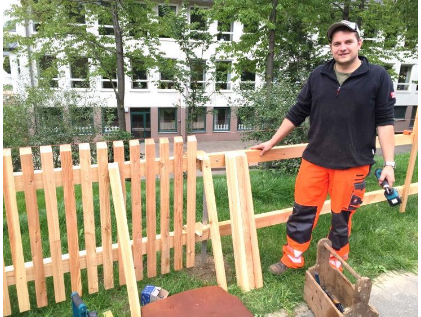
Das Bild zeigt den neuen Bauhofmitarbeiter Heiko Greim bei der Montage des Zaunes.
