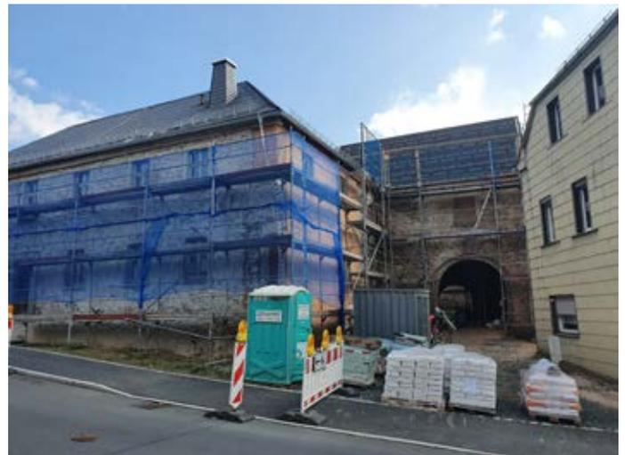
**Münchberger Straße 1:** Das Notdach der Steinscheune wurde nach fast einem Jahr Bauzeit entfernt und die Dachkonstruktion durch die Zimmerei Strößner aus Schweinsbach fertig gestellt. Es folgen als nächstes die Klempnerarbeiten und die Eindeckung des Daches mit Naturschiefer.
