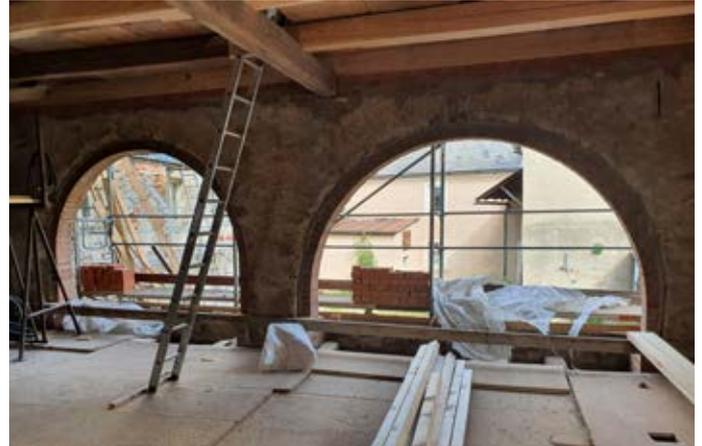
**Münchberger Straße 1:** Die Firma Schneider aus Sparneck ertüchtigte die Rundbögen im Obergeschoss der Steinscheune. Im Deckenbereich sind die durch die Firma Strößner aus Schweinsbach sanierten Deckenbalken ersichtlich.
